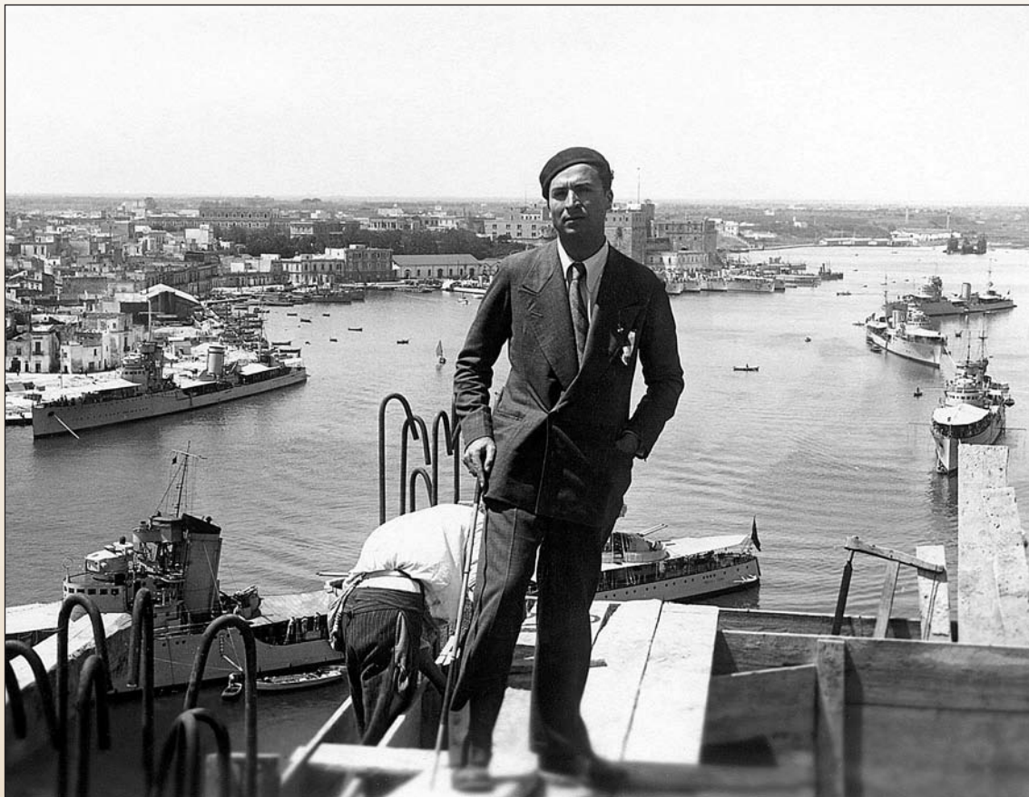
La costruzione del Monumento al Marinaio, inaugurato il 4 novembre 1933
